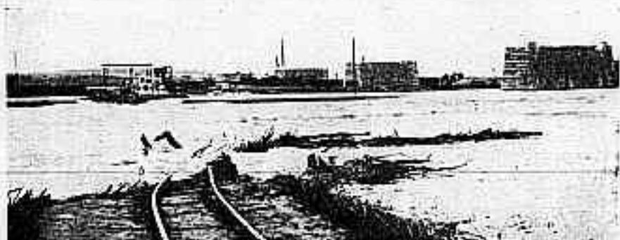
Abb. 6. Hochwasser auf der Baustelle.
