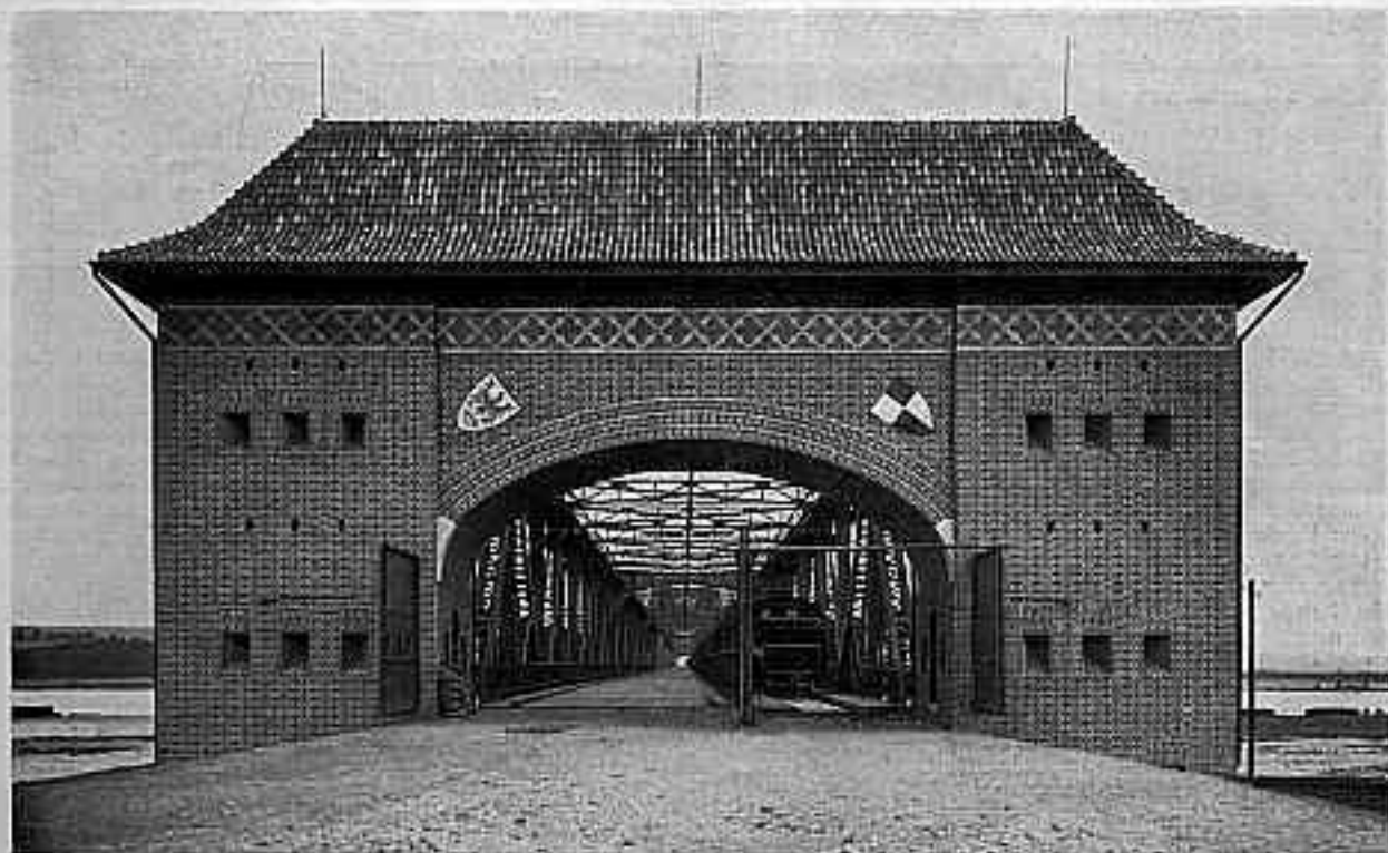
Abb. 1. Die Weichselbrücke bei Marienwerder, Turmaufbau.
