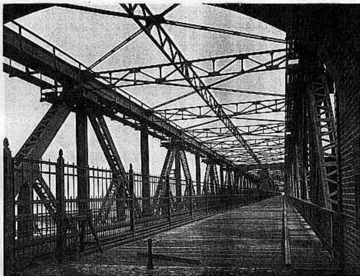
Abb. 14. Innenansicht der Brücke, Geländer und Trennungsgitter.
