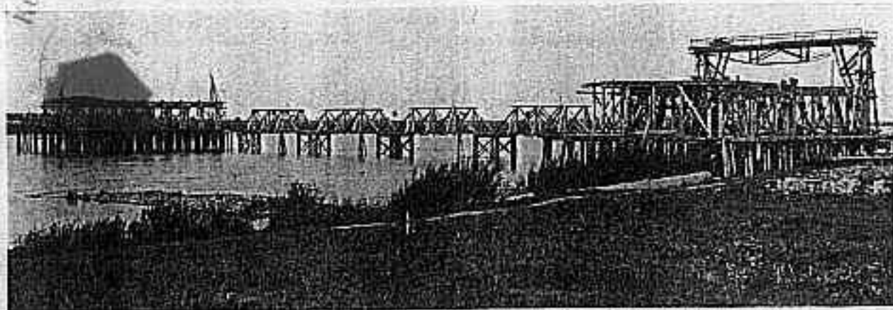
Abb. 9. Werksteg zwischen rechtsseitigen Strompfeiler und östlichem Ufer.
