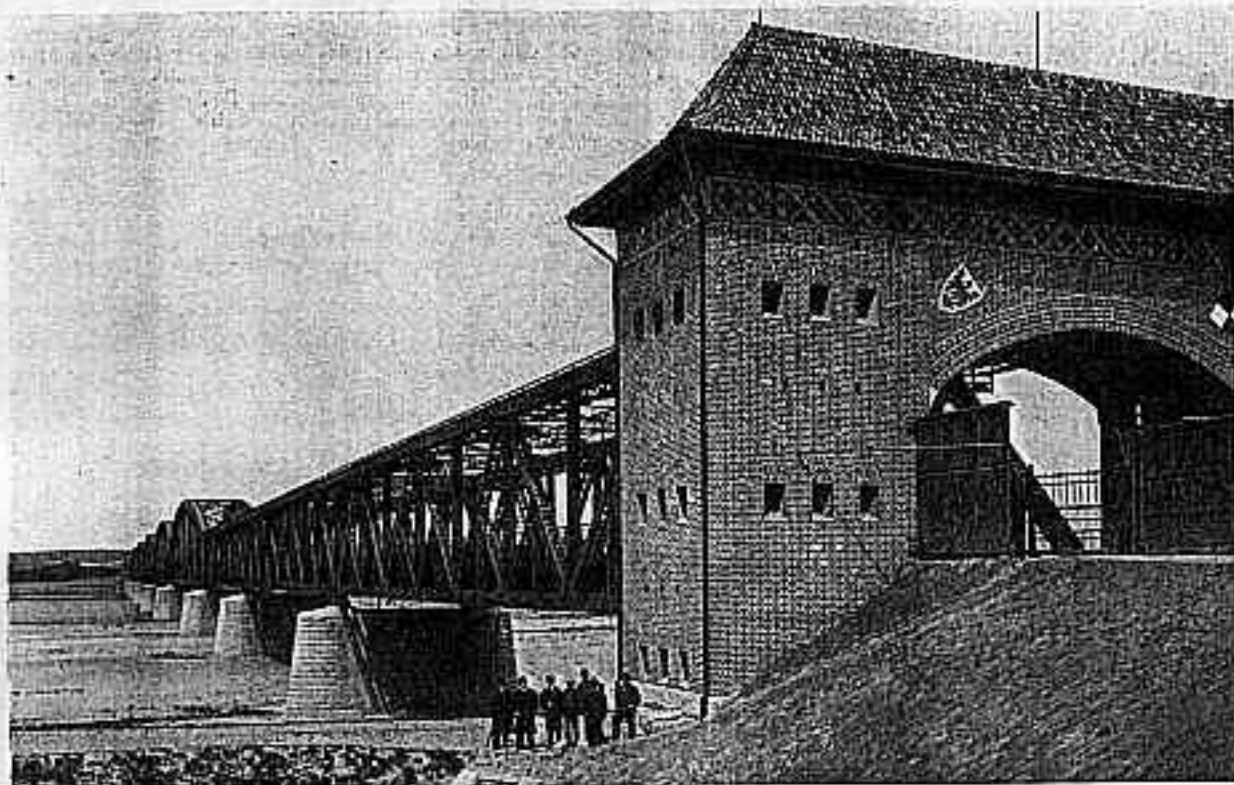
Abb. 8. Die Weichselbrücke bei Marienwerder. Gesamtansicht.
